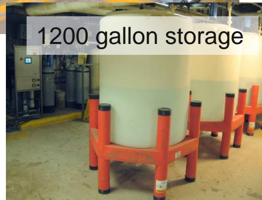
DI Water System
